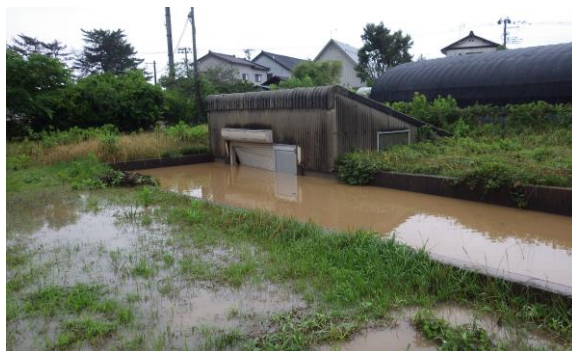
[ 宮内 除塵機建屋 ]
