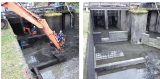
右岸調整水槽土砂上げ工事
