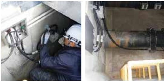
高田揚水機場流量計交換工事
