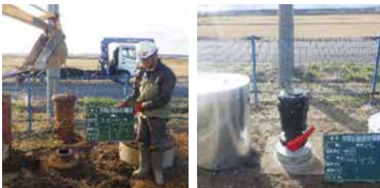
寺田・本楯揚水機場管水路付帯設備補修工事 (空気弁交換)
