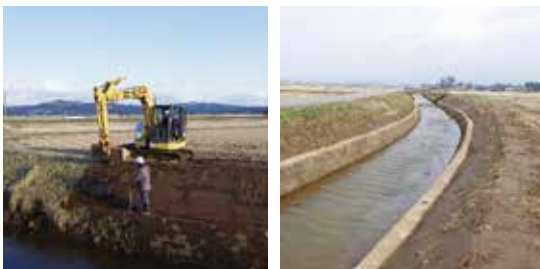
宮内幹線排水路法面補修工事(法面整形)
